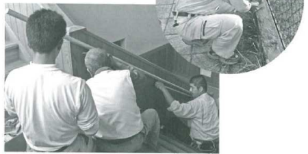
フェンスを修繕する組合員 階段に手すりを設置する組合員
