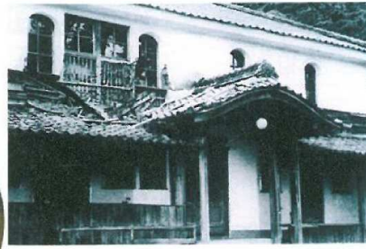
▲昭和44年当時の荒廃した開明学校
