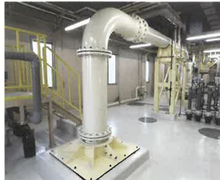
■酸素溶解循環配管(Uチューブ)
