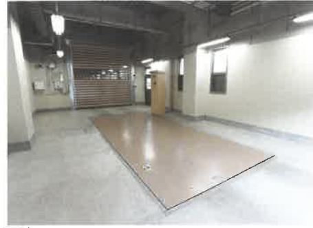
■搬入し尿等計量装置
