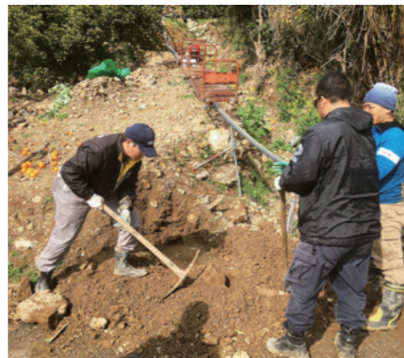
園地を掘り、スプリンクラーの配管を探す
