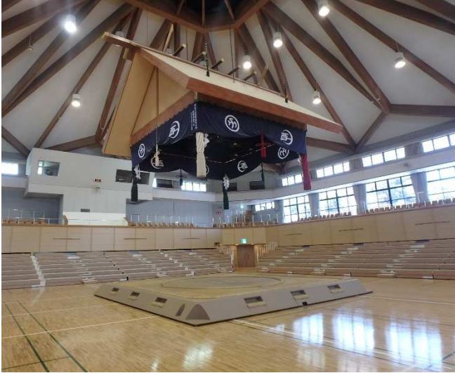
▲復旧工事を終えたアリーナ
