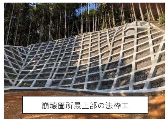
崩壊箇所最上部の法枠工
