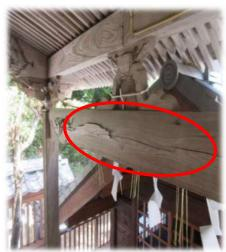
全体的に経年劣化とシロアリの被害がありました。 場所によってはボロボロに痩せてしまっていま す・・・。本殿へ上がる階段の側面は板が外れてい るし、柱や手すりなどは継ぎ目が浮いてしまって いますね。
