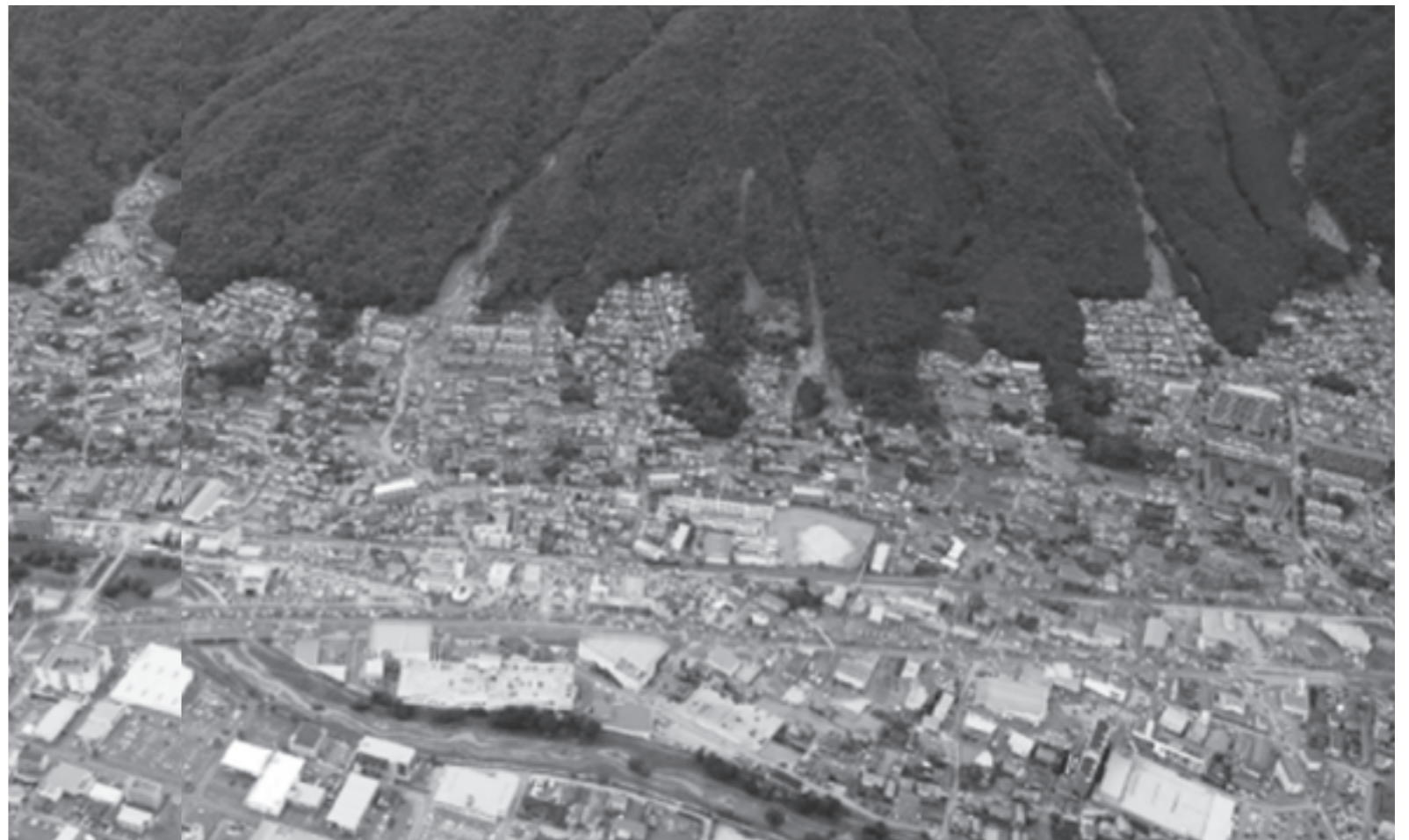
山並みに入る縦すじは土砂崩れの跡（斜め空中写真 広島市安佐南区八木付近）
