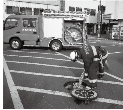
防火水槽の使用例
