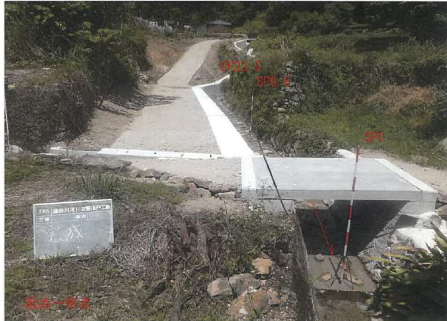
福田川河川災害復旧工事
