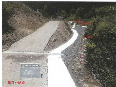
福田川河川災害復旧工事
