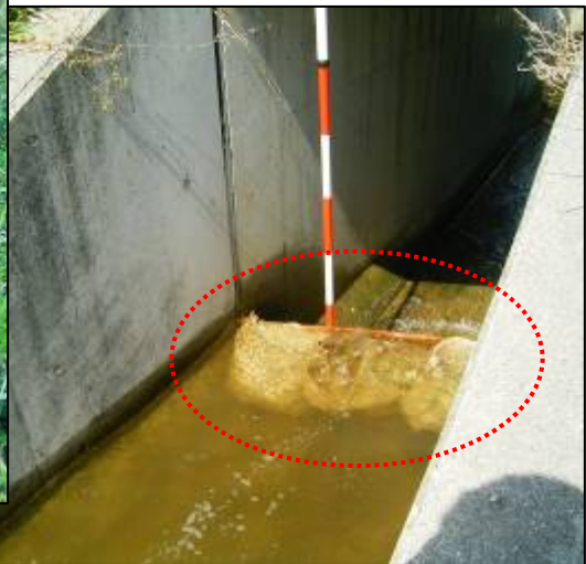
【写真⑥ 堰板と土のうによる洪水吐の堰上げ】
