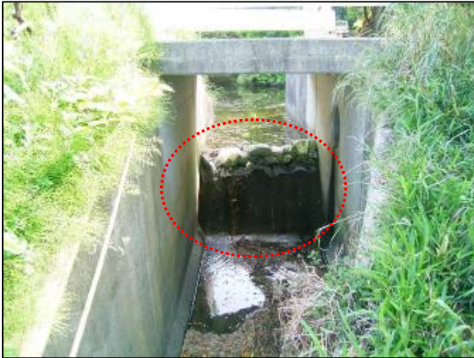
【写真⑤ 土のうによる洪水吐の堰上げ】
