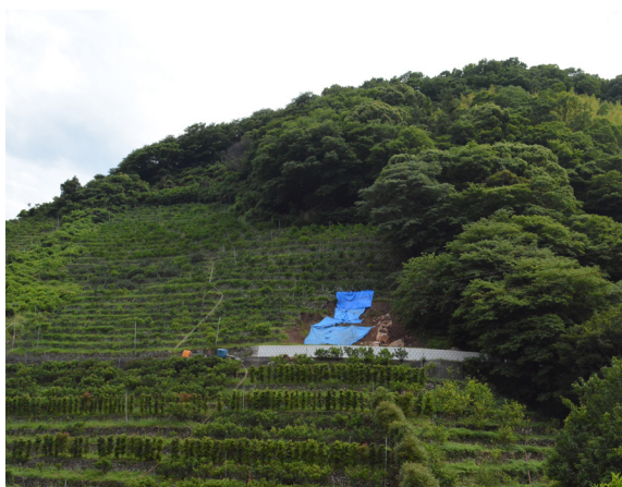
崩れた段畑の一面
