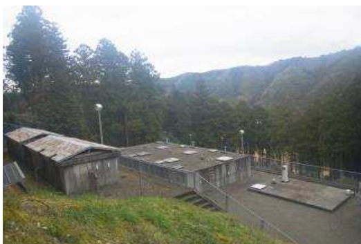
下相上浄水場
