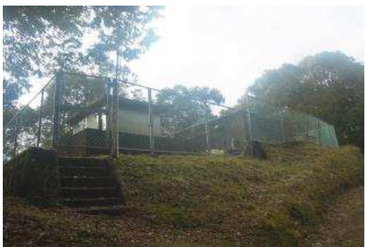
下相下浄水場
