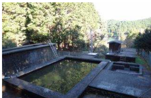
西山田浄水場
