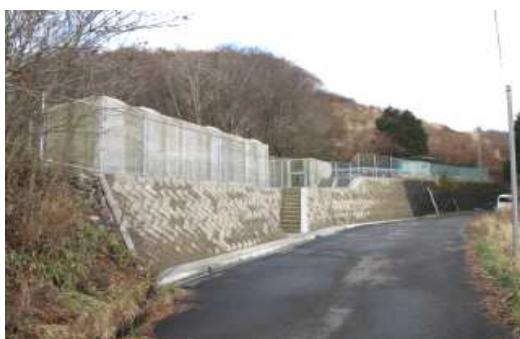
大野ヶ原浄水場
