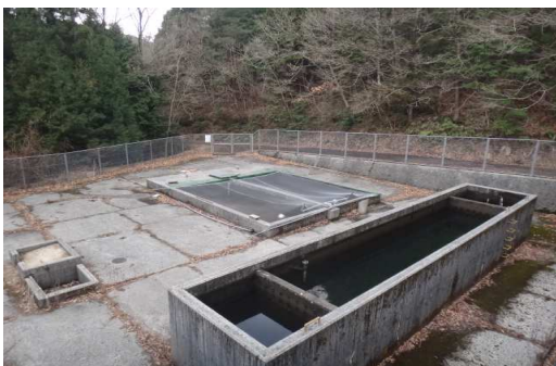
田之筋浄水場
