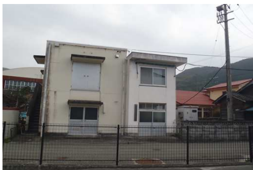
津布理浄水場
