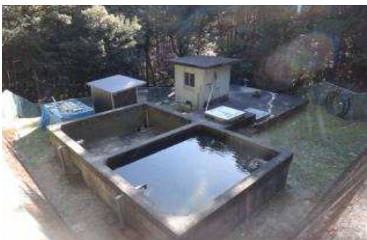
真土西浄水場
