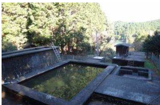
西山田浄水場
