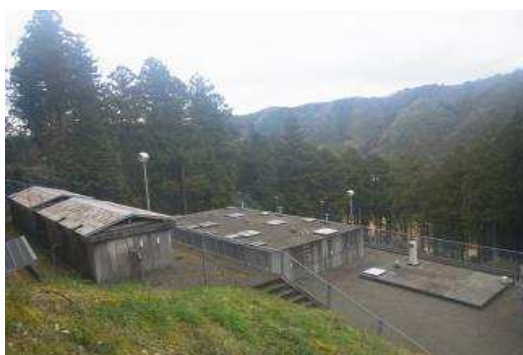
下相上浄水場
