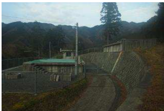
川津南浄水場
