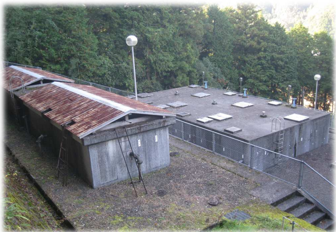
西予市城川地区 下相上簡易水道
