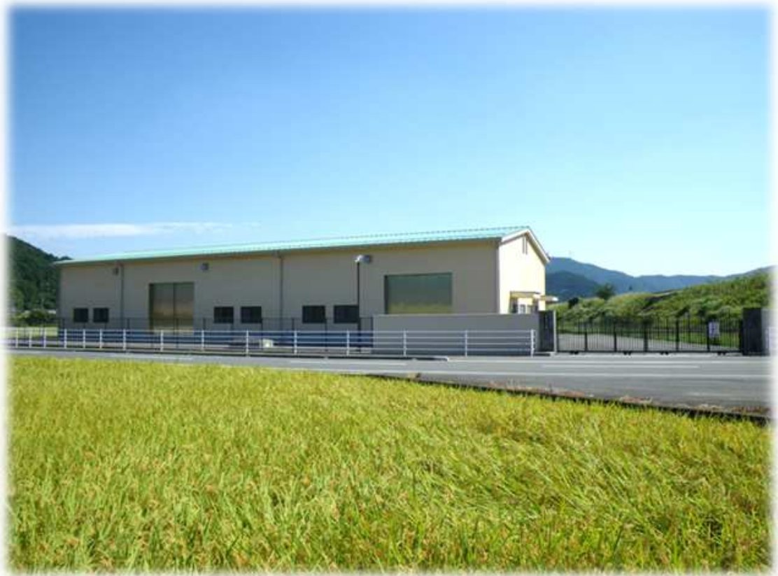
宇和給水区域 明石浄水場
