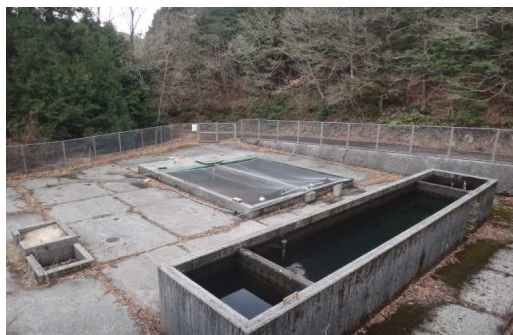
田之筋浄水場
