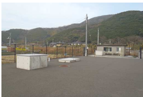
南地区浄水場
