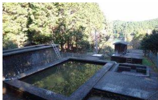
西山田浄水場
