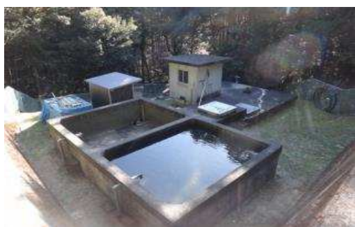
真土西浄水場
