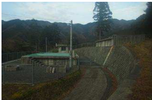
川津南浄水場
