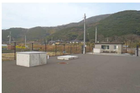
南地区浄水場
