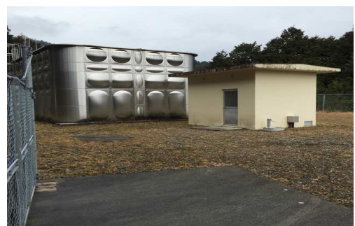
文治が駄場浄水場
