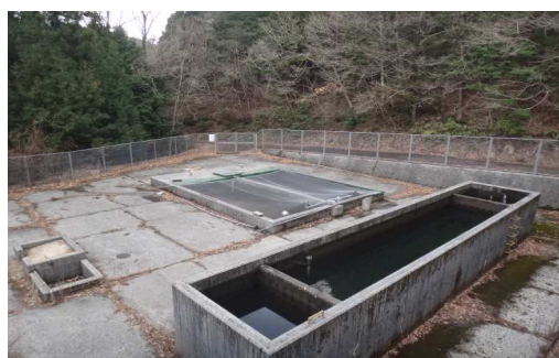
田之筋浄水場
