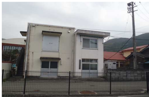
津布理浄水場
