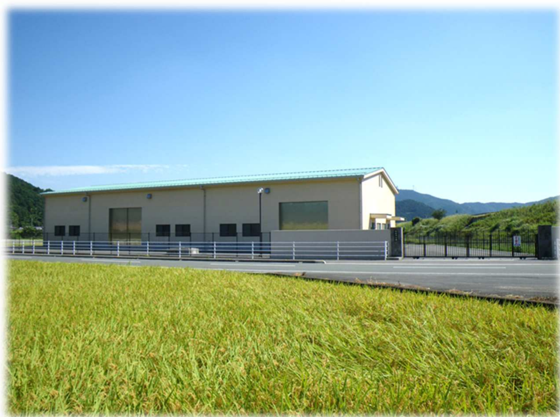
宇和給水区域 明石浄水場
