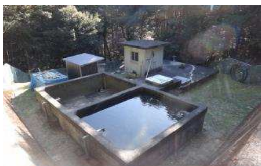
真土西浄水場
