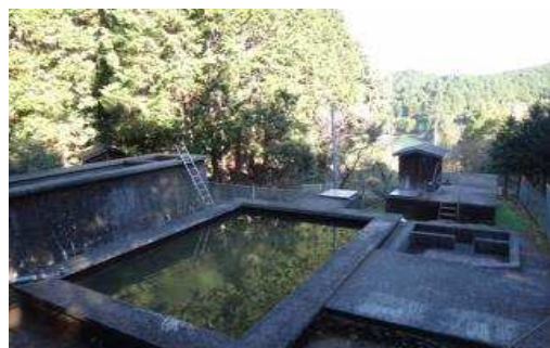
西山田浄水場
