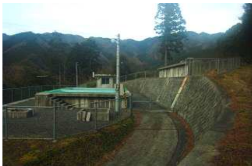
川津南浄水場
