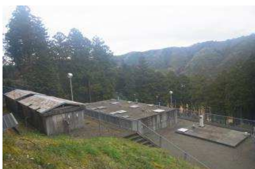
下相上浄水場
