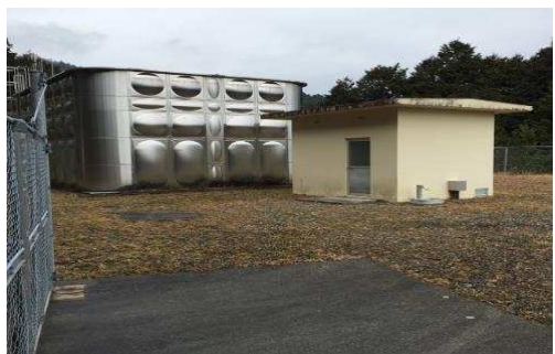
文治が駄場浄水場
