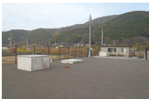
南地区浄水場
