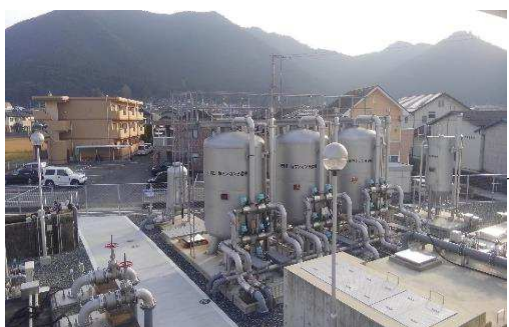
上松葉浄水場
