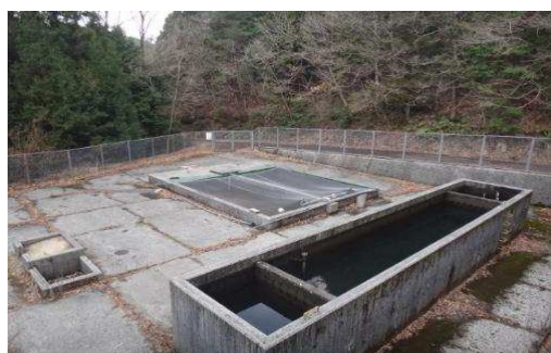
田之筋浄水場
