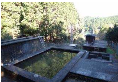
西山田浄水場
