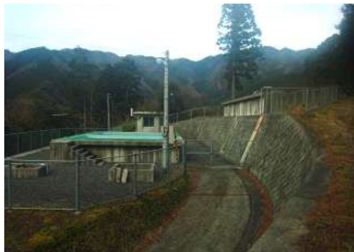
川津南浄水場
