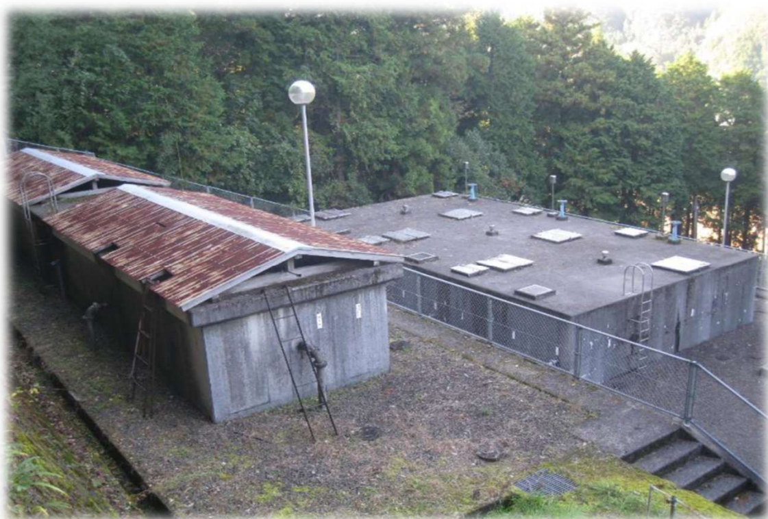
西予市城川地区 下相上簡易水道
