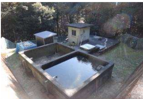
真土西浄水場
