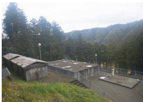
下相上浄水場
