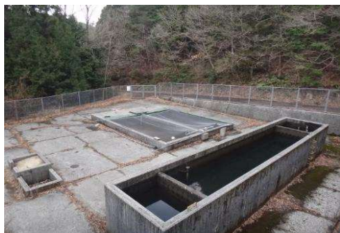
田之筋浄水場
