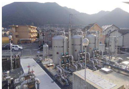
上松葉浄水場
