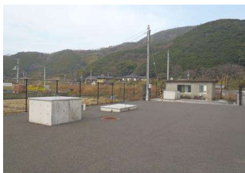
南地区浄水場
