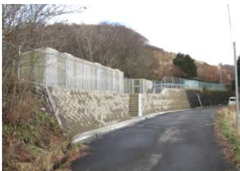
大野ヶ原浄水場
