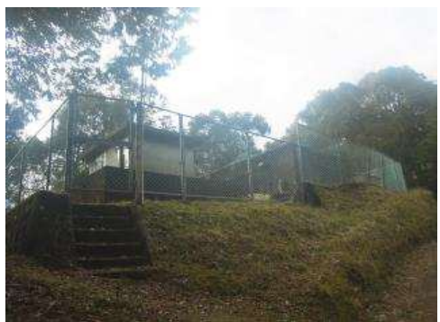
下相下浄水場
