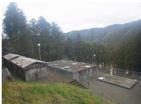
下相上浄水場
