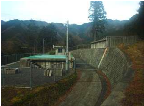
川津南浄水場
