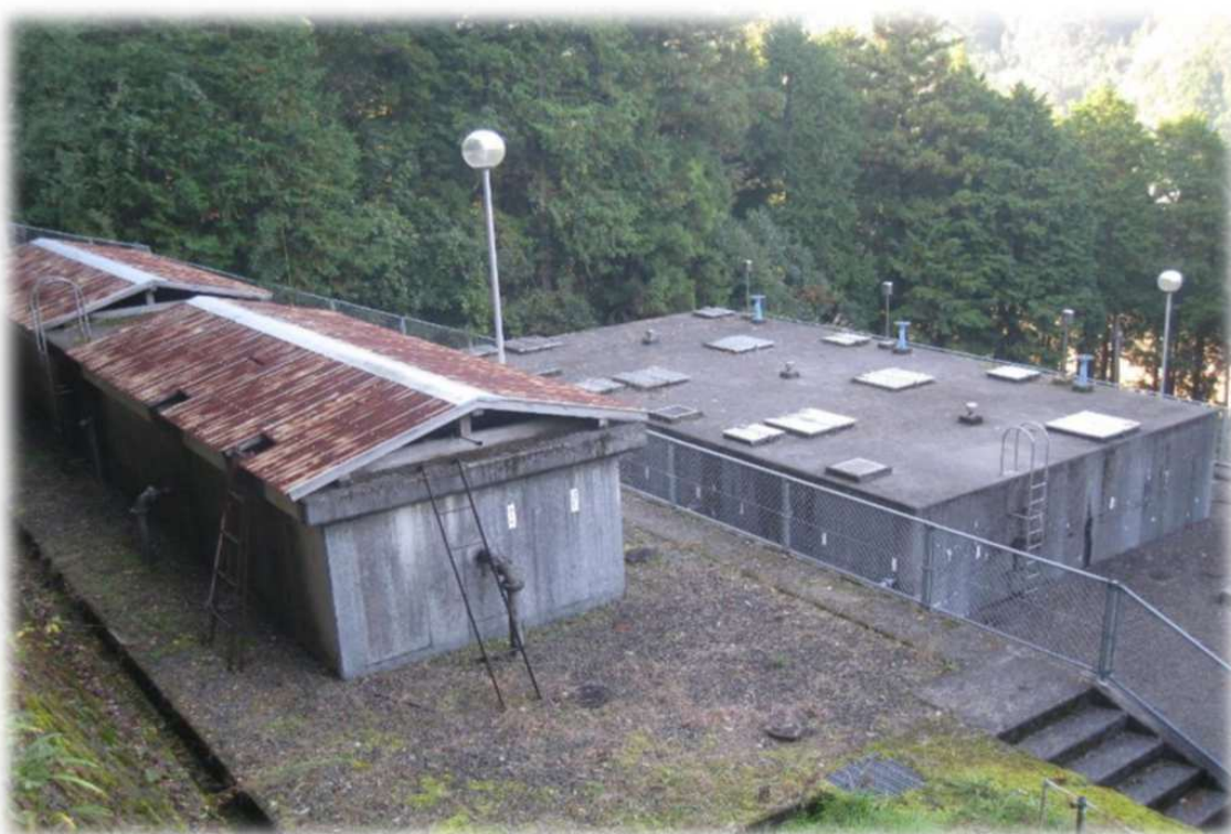
西予市城川地区 下相上簡易水道
