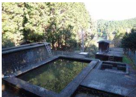
西山田浄水場
