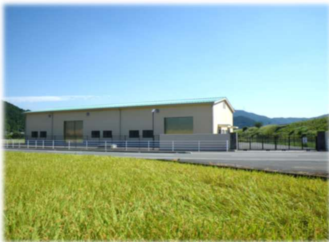
宇和給水区域 明石浄水場
