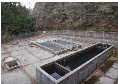
田之筋浄水場
