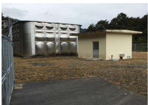
文治が駄場浄水場
