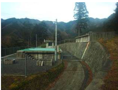
川津南浄水場
