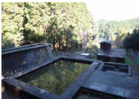
西山田浄水場
