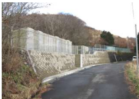
大野ヶ原浄水場
