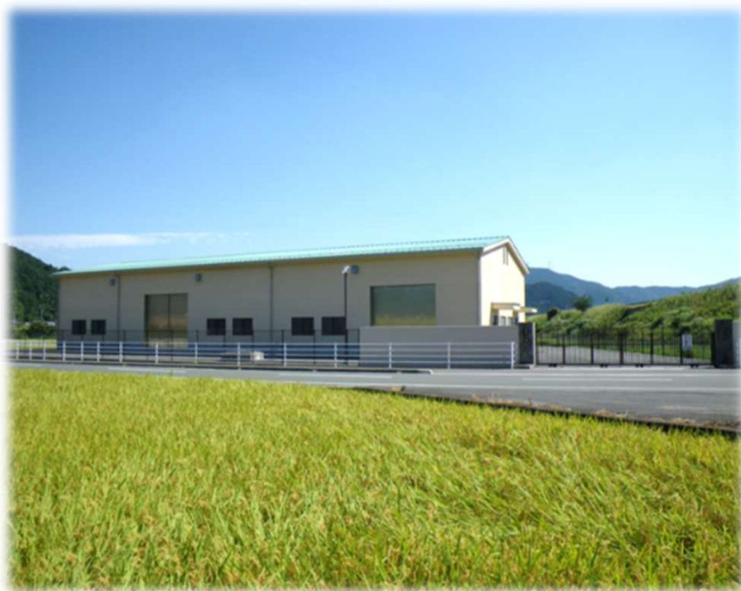
宇和給水区域 明石浄水場
