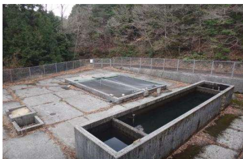
田之筋浄水場
