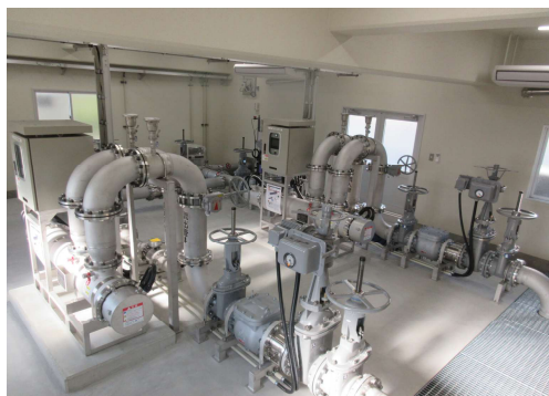
津布理浄水場
