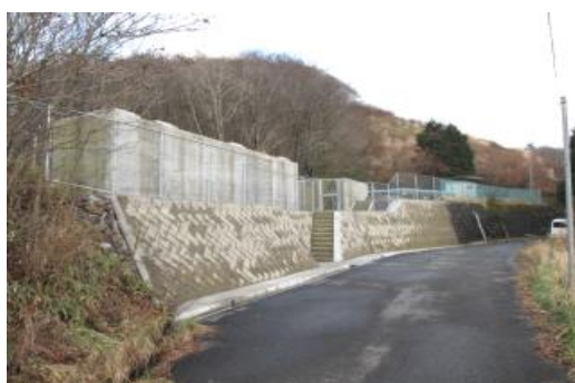
大野ヶ原浄水場
