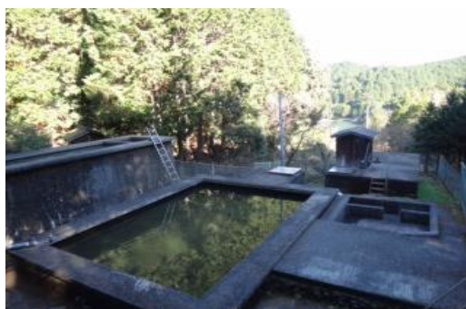
西山田浄水場
