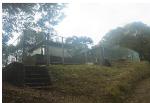
下相下浄水場
