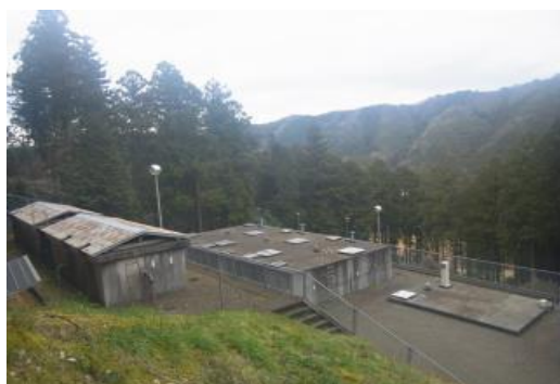
下相上浄水場
