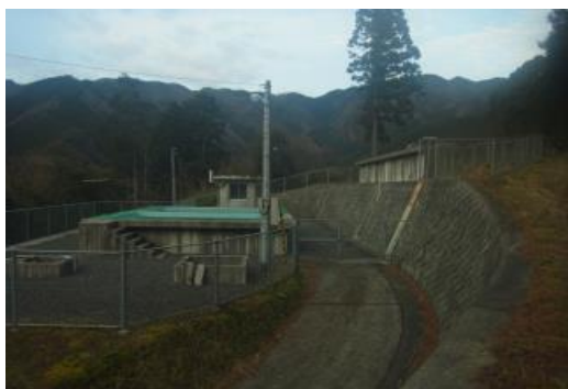
川津南浄水場
