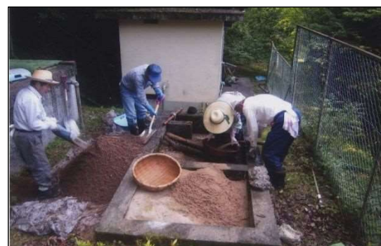
ろ過砂の洗浄状況
