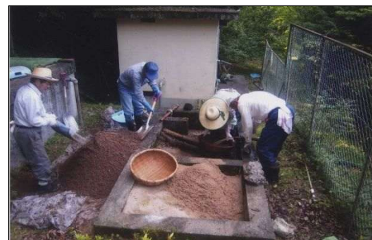
ろ過砂の洗浄状況
