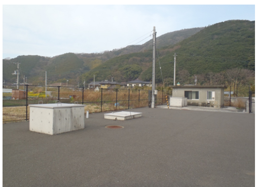
南地区浄水場
