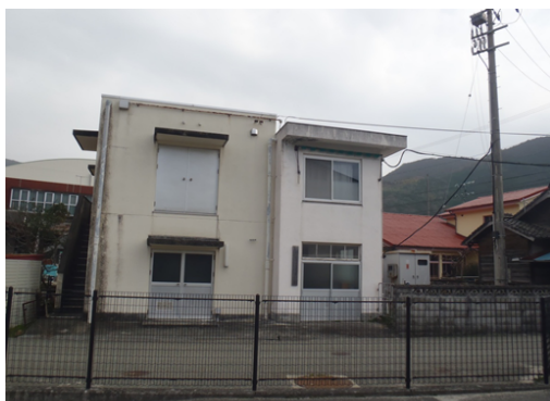
津布理浄水場
