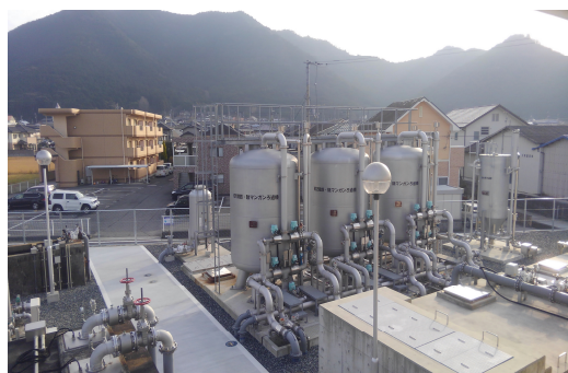
上松葉浄水場
