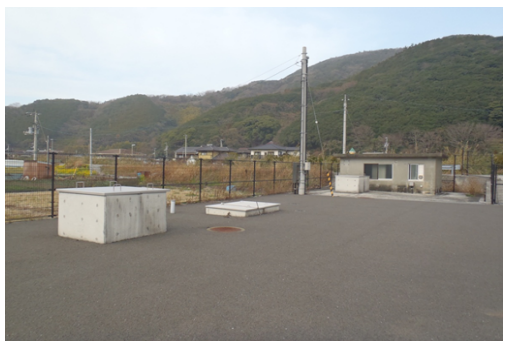
南地区浄水場
