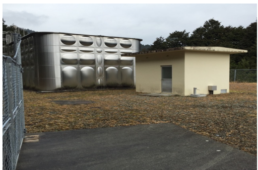
文治が駄場浄水場
