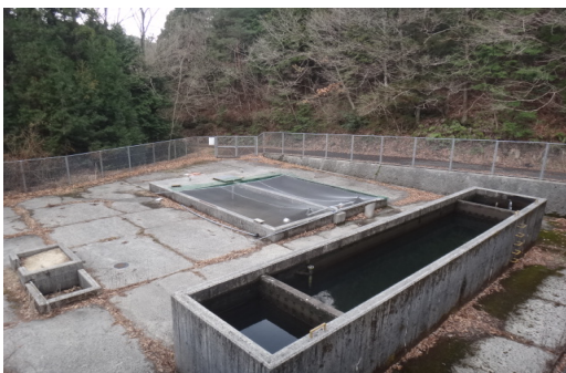
田之筋浄水場
