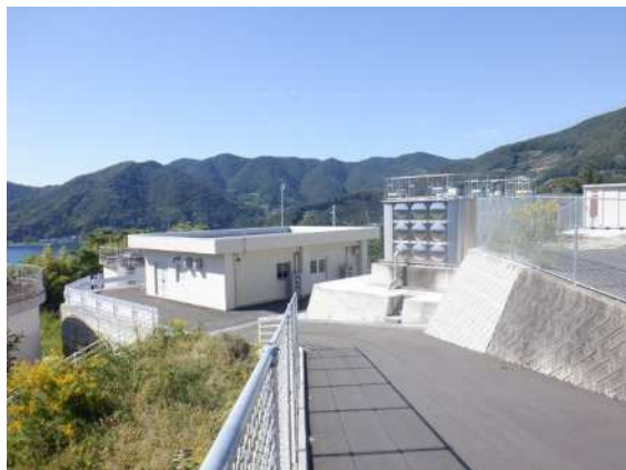
津布理浄水場
