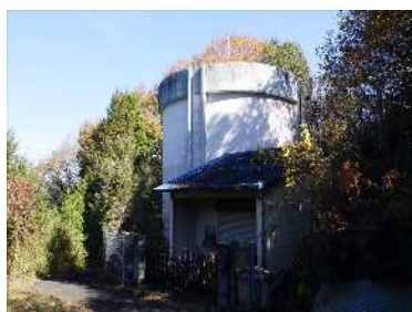
岡配水池 V=1000m 3 (H2)
