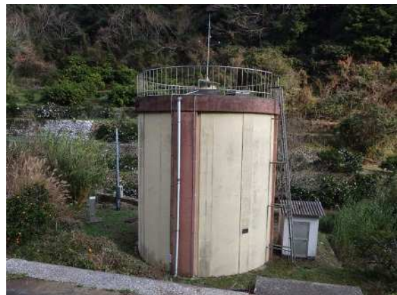
高山西配水池
