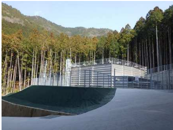
上松葉配水池
