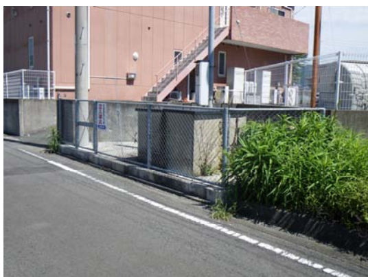
上松葉 2 水源地
