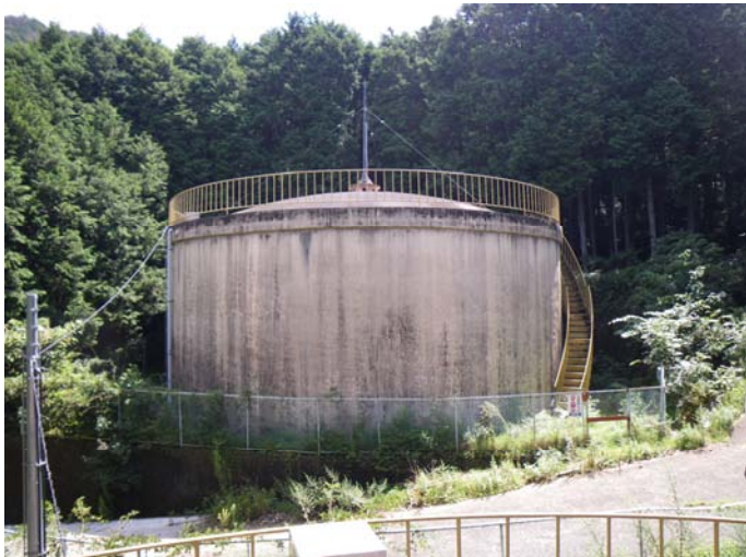
上松葉第 2 配水池
