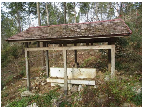
野村ダムロジ中央（⑤調理棟・⑥トイレ）
