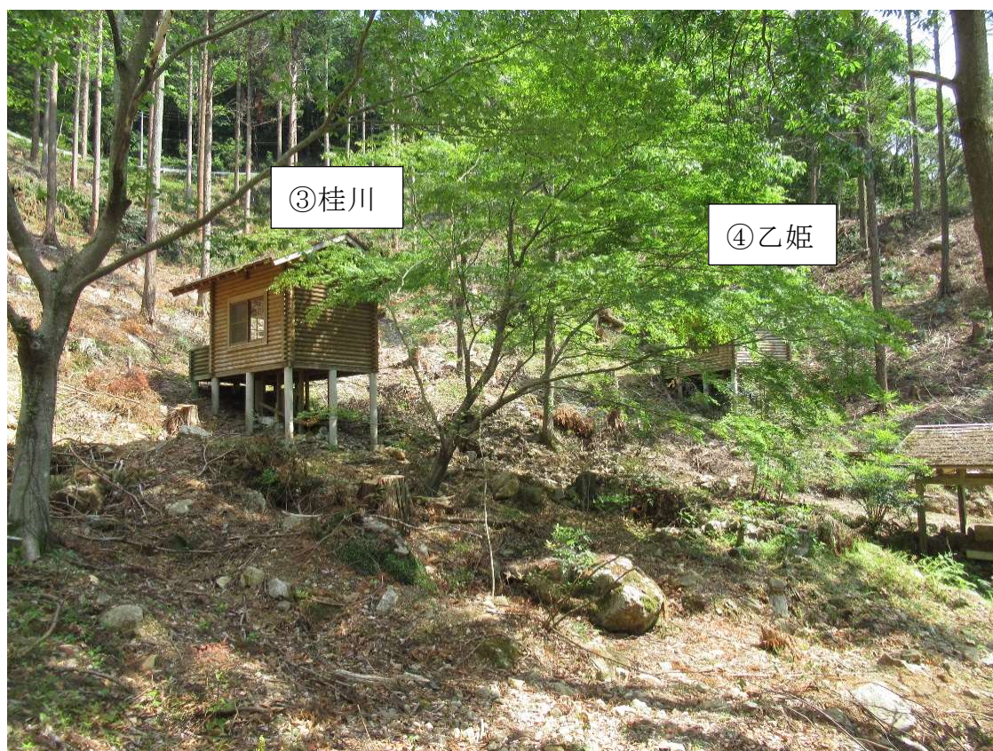
野村ダムロジ西側（桂川、乙姫）
