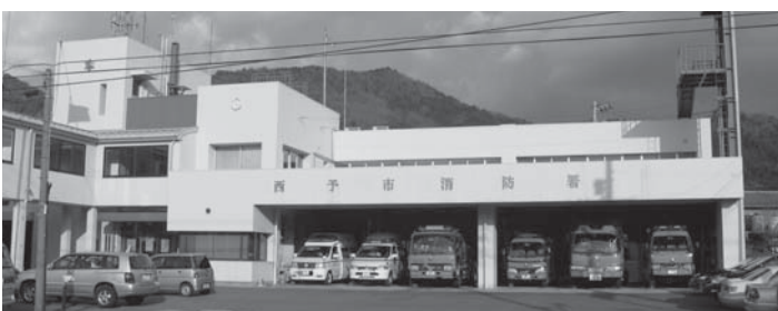
改修が待たれる消防本部
