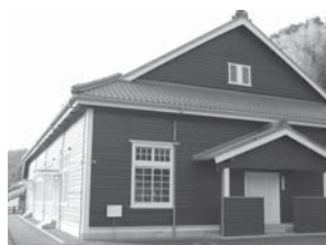
大空間木造トラスの旧宇和町小学校講堂
