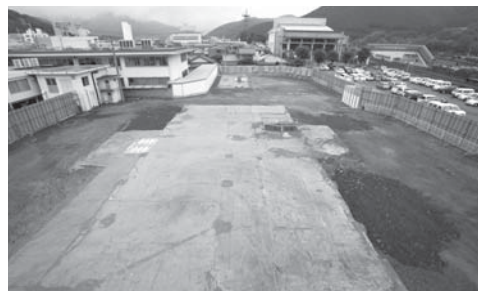
庁舎建設予定地
