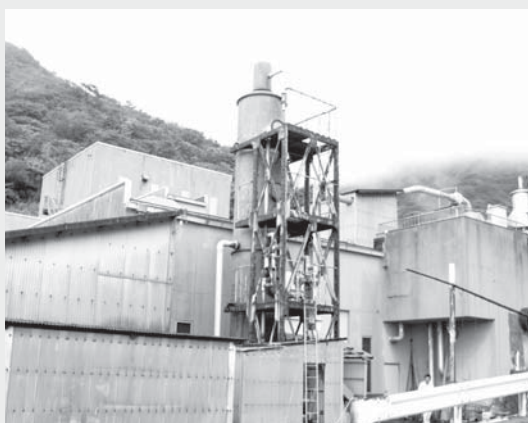
老朽化した西部衛生センター(明浜)
