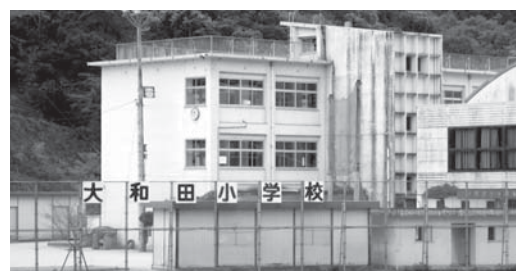
耐震工事が予定されている大和田小学校
