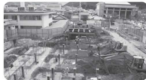
工事が進む新庁舎
