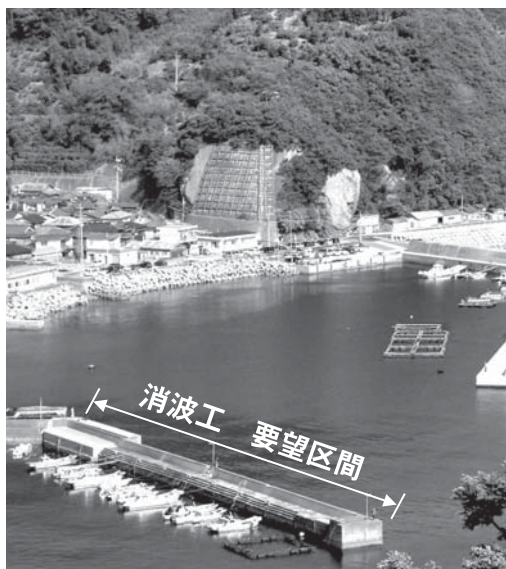
消波ブロックの設置予定の田之浜漁港
