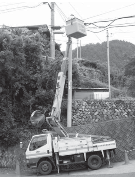
ケーブル敷設
