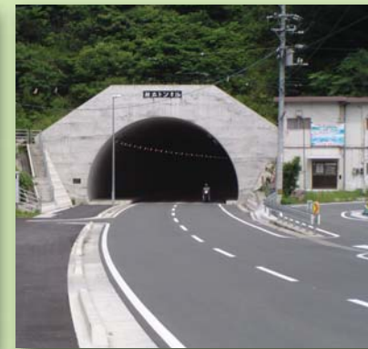
改良された新道
