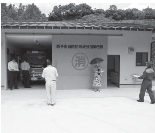
消防詰所(魚成分団第6部)
