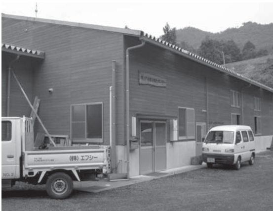
ペレット建設予定地(城川)
