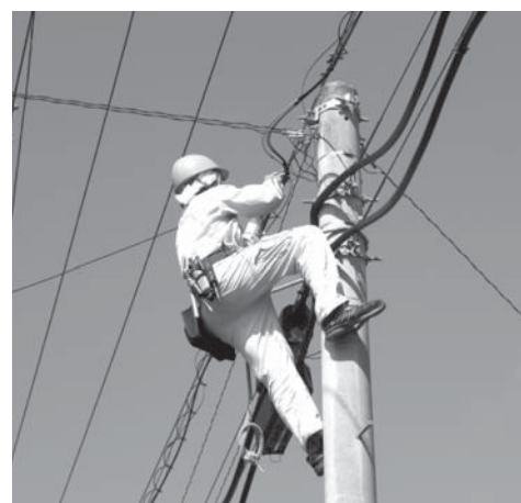
急がれる引込み工事
