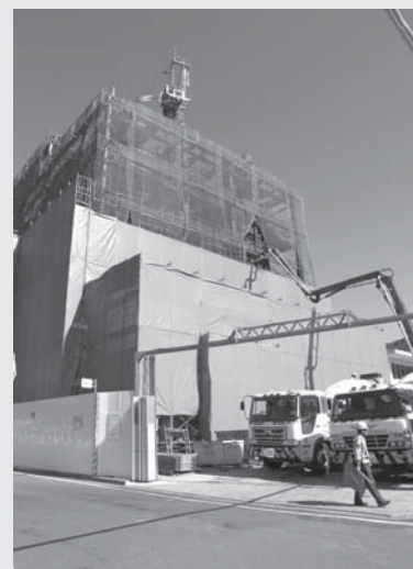
建設が進む新庁舎
