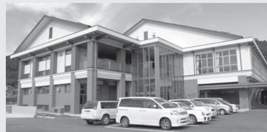
完成した宇和中体育館
