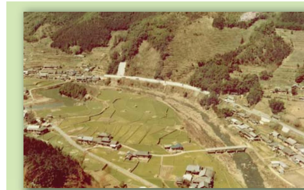
工事前の明間地区
