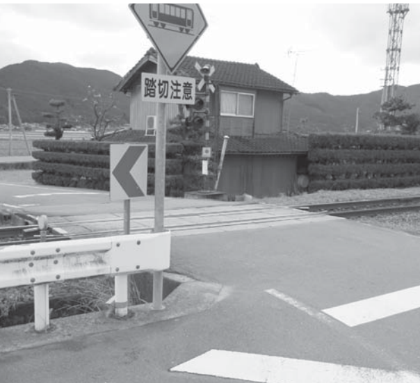
早期の踏切改修が望まれる伊予石城駅
