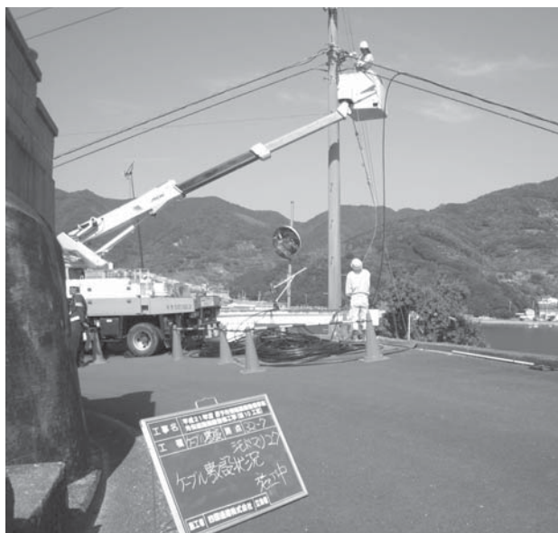
光ケーブル幹線工事
