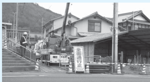
公共工事現場
