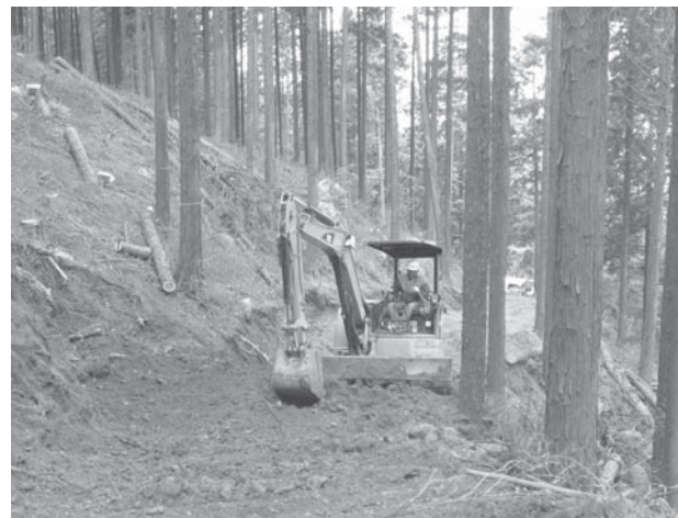
中核作業道施工状況
