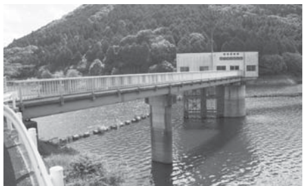
南予用水取水塔(野村ダム)
