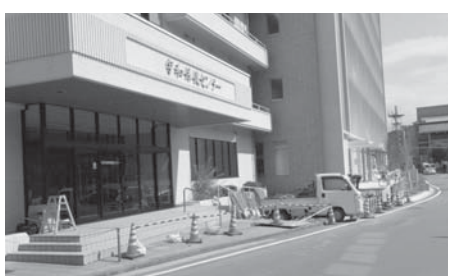
改修工事が進む保健センター
