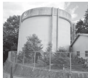
野村上水道高区配水池
