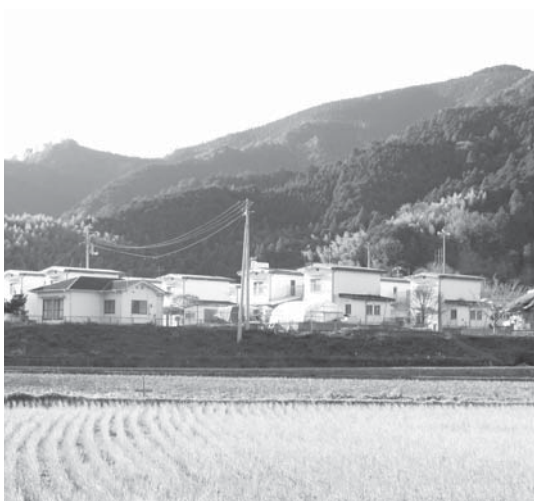
改修が必要な改良住宅(宇和伊延)
