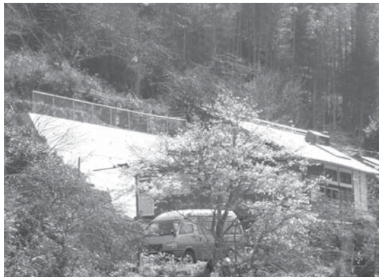
急傾斜地崩壊防止対策事(城川)
