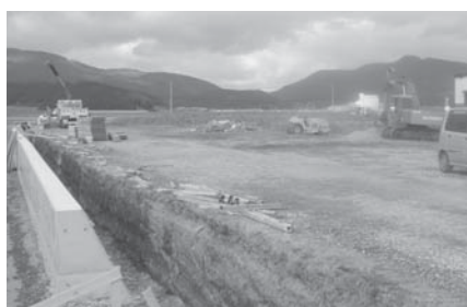
新病院造成着工
