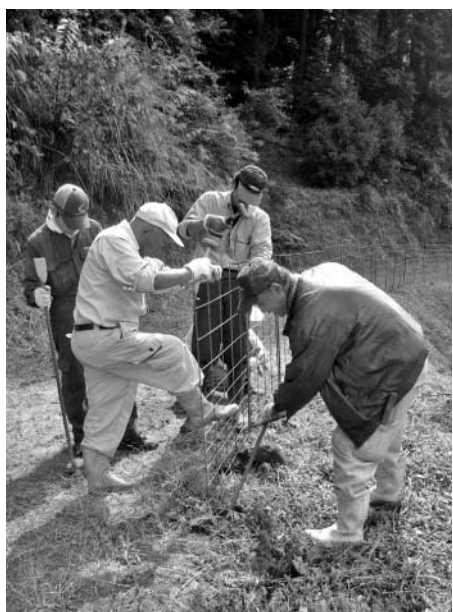
いのしし柵設置
