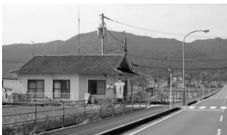
廃止予定の西山田駐在所
