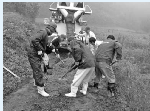
農道コンクリート舗装
