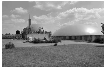
バイオマス発電所（ドイツ）
