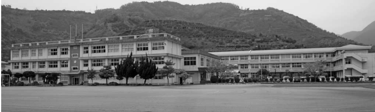
統合校舎建設予定地
