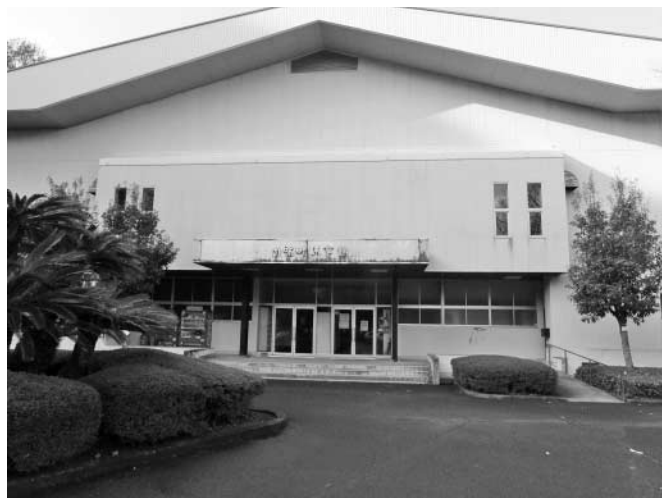
避難施設の宇和町体育館
