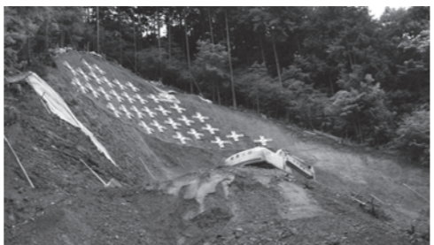
林道内場樽線復旧工事(野村町)
