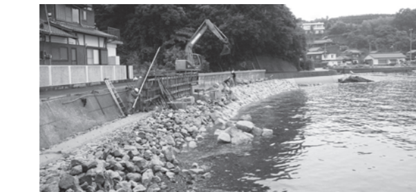
皆江地区護岸工事(三瓶町)
