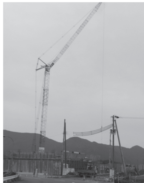
建設中の新市立病院
