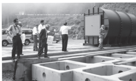
建設中の産業廃棄物処理施設
